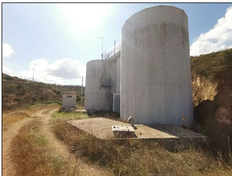
Figura 30: Torri piezometriche dell'acquedotto.
