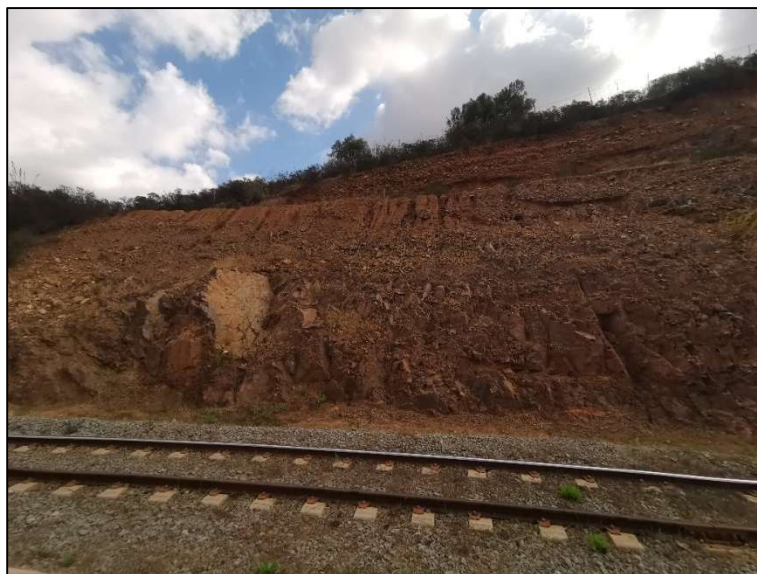
Figura 20: Potenziale corpo di frana con ciottoli e blocchi rocciosi immersi in una matrice sabbiosa limosa in cui si riconoscono forme di erosione superficiale.
