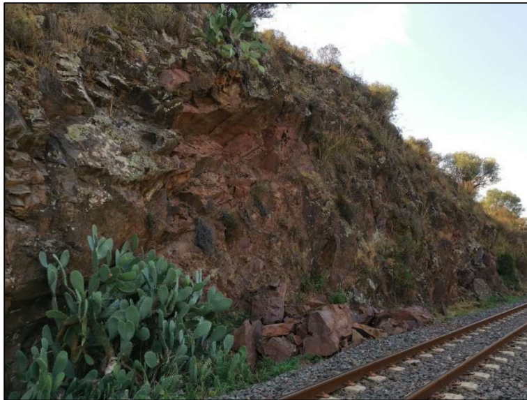
Figura 15: Affioramento in prossimità della ferrovia con blocchi di crolli nelle vicinanze delle rotaie.
